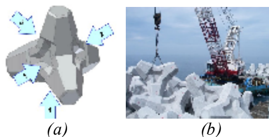
Hình 1. Mô hình cấu kiện RAKUNA-IV (a) và công tác thi công lắp đặt khối phủ (b)
